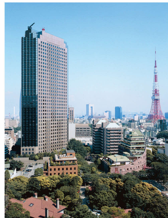
神谷町のシンボリックなタワーとして建つ「城山トラストタワー」の30階に、高橋綜合法律事務所はオフィスを構える
